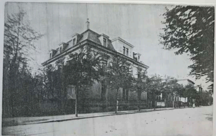
SCHNORRSTRASSE 80 IN DRESDEN
